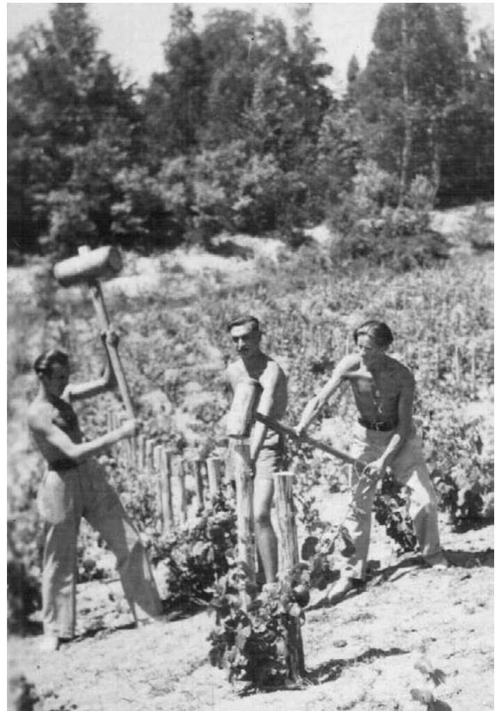
Wymiana słupków na winnicy
